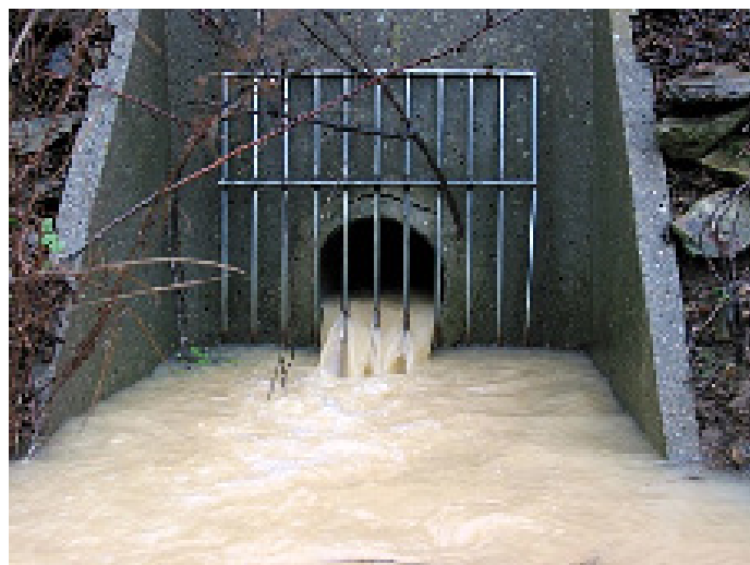
Fig.9: Canale de drenaj subterane
